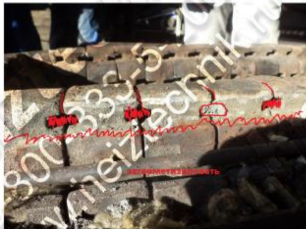
Герметизация горелки ЕКОМАХ
